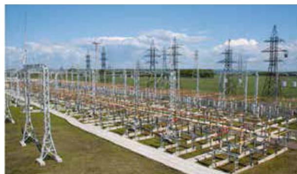
КТП-СЭЩ- Б(М) 220/110/35/10(6) кВ
