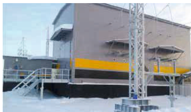
ЗРУ-СЭЩ С КРУЭ-СЭЩ-110 кВ
